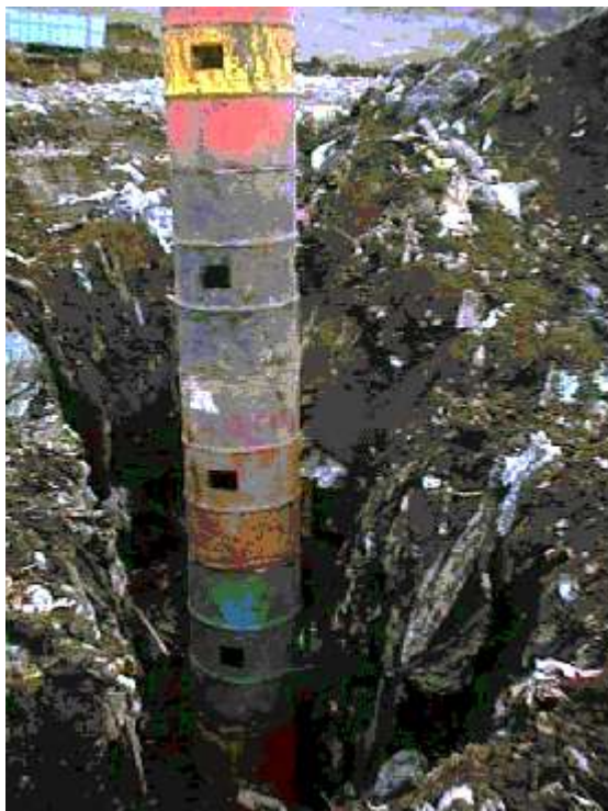
Fig. 3: En el vertedero de Coyhaique fueron instalados dos pozos de venteo artesanales para el drenaje de biogás y para mayor seguridad en la operación del vertedero
