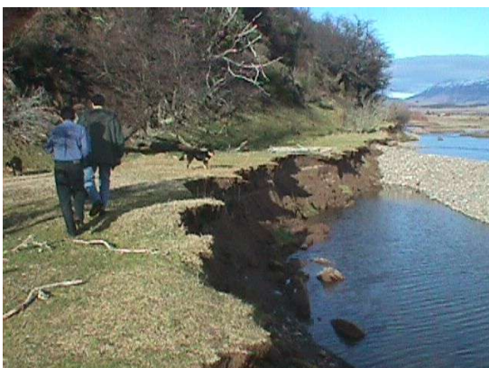
Fig. 36: Las riberas del Río Simpson en el sector Ensenada está expuestas a erosión Para preservar terrenos ribereños productivos se han realizado trabajos de defensa fluvial en cooperación con el MOP / DOH
