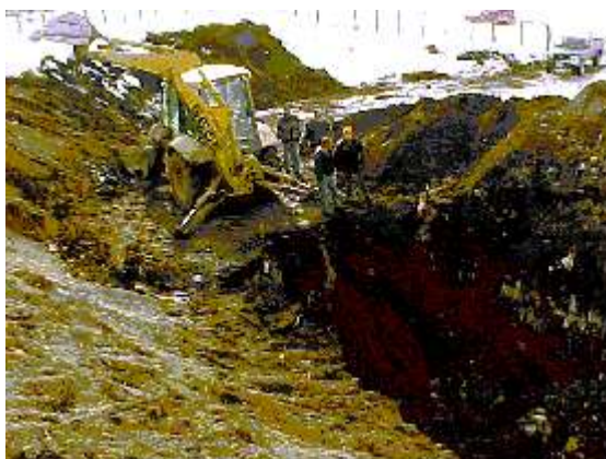
Fig. 1: En el vertedero rural de Ñirehuao se excavaron nuevas zanjas para mejorar la operación ($ 1,1 millones)
