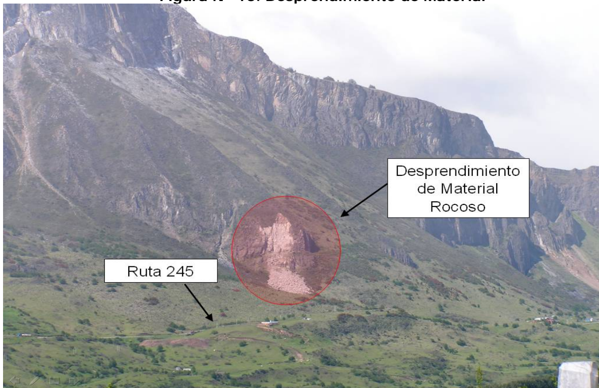
Figura N° 10. Desprendimiento de Material
