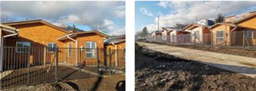
Fotografías loteo "Los Leñeros" 6 viviendas, realizado en lote de reserva del SERVIU Region de Aysen en la Pobl. Clotario Blest en la ciudad de Coyhaique.
