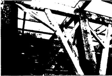
Fotografía N° 16: Falta de pintura de terminación en refuerzos metálicos.
