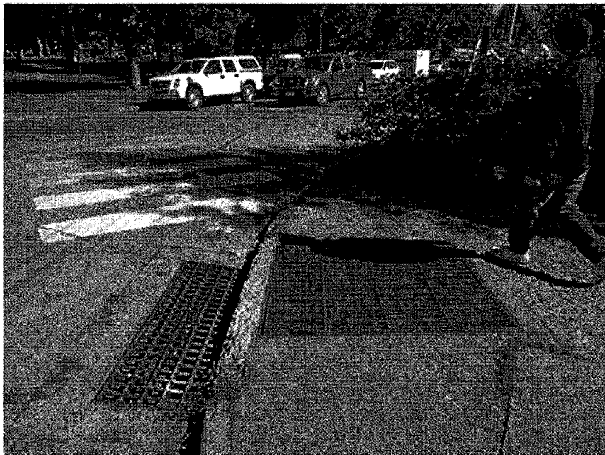
REPOSICION ACERAS PERIMETRO PLAZA DE ARMAS DE COYHAIQUE
